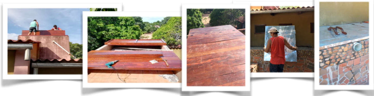
Montage van de deksels bovenop de watertoren van het gastenverblijf.
